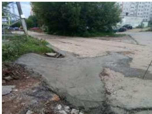
В ходе проведенных работ сделан желоб для отвода воды в ливневку, забетонированы и укреплены плиты. Сделана искусственная неровность на улице Орджоникидзе на пересечении со Стахановской, чтобы отвезти воду, идущую сверху со стороны Дзержинского в ливневку и предотвратить её дальнейшее движение через участок плит.
