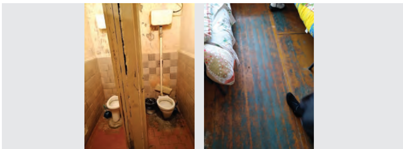
Санузел и жилая комната КОГПОАУ «Кировский автодорожный техникум»
